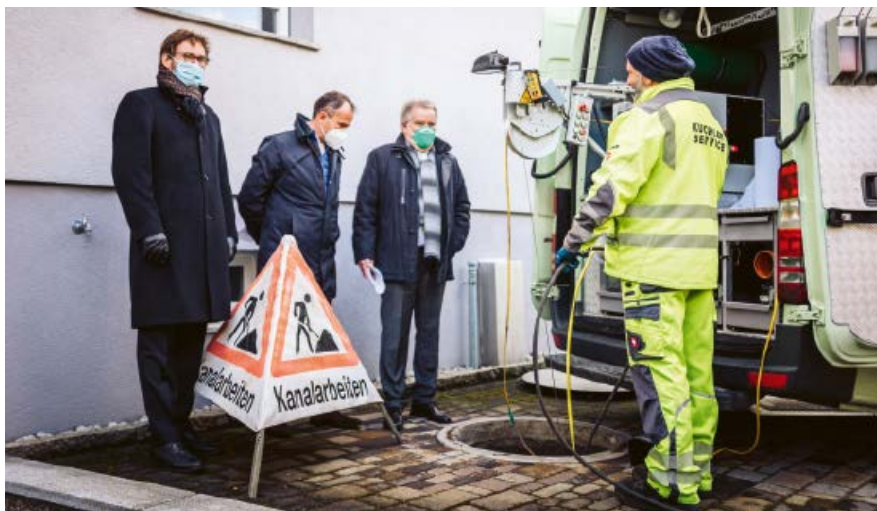
Blick in die Kanalisation (v. l. n. r.): Dr. Moritz Heidecker (Bürgermeister der Stadt Ettlingen), André Hildebrand (Geschäftsführer des DWA Landesverbands Baden-Württemberg), Franz Untersteller (Umweltminister Baden-Württemberg) mit einem Mitarbeiter der Inspektionsfirma
